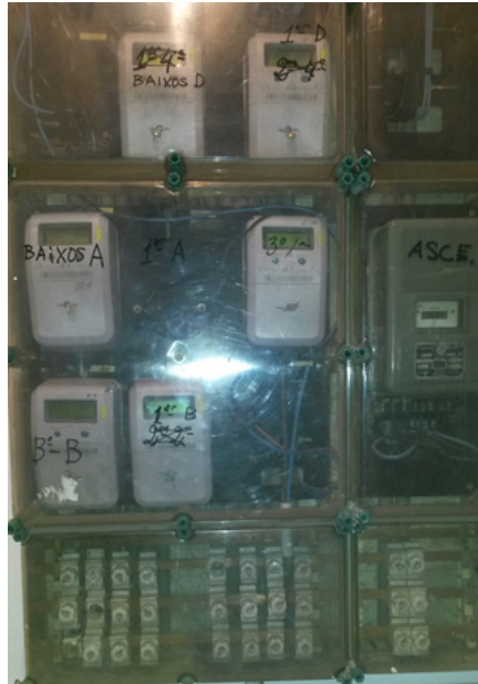
Quadre comptadors d'una comunitat de veïns. Comptadors a dalt i fusibles a baix.
