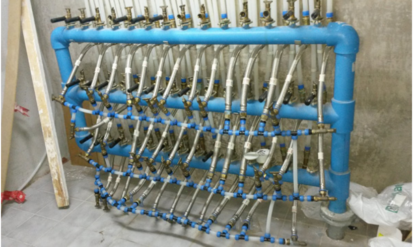
Exemple d'una punxada d'aigua a tot un veïnat
