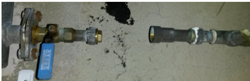
Com veïem, falta el comptador, en aquest cas hi ha una clau de pas just abans i un tap.
